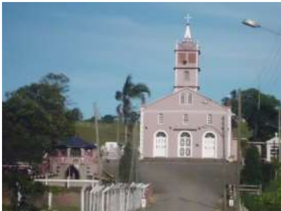
Figura 2: Igreja na comunidade Aratingaúba, Imaruí, SC.
